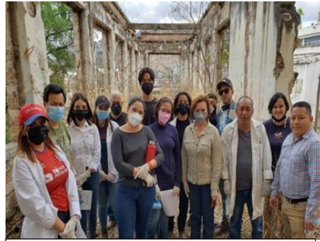
Evaluación de mural al fresco en antiguo edificio de la ENEE, Tegucigalpa
