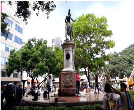
Trabajos de conservación de escultura ecuestre Francisco Morazán, Tegucigalpa
