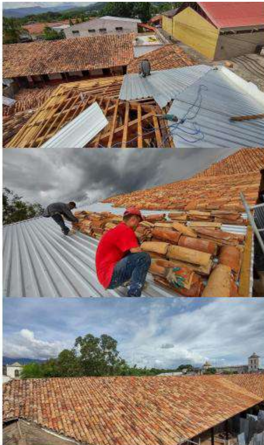
Imagen 9. Imágenes del antes y después de la obra.
