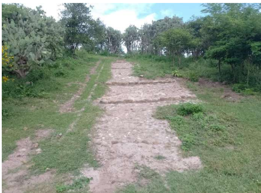
Imagen general del talud
