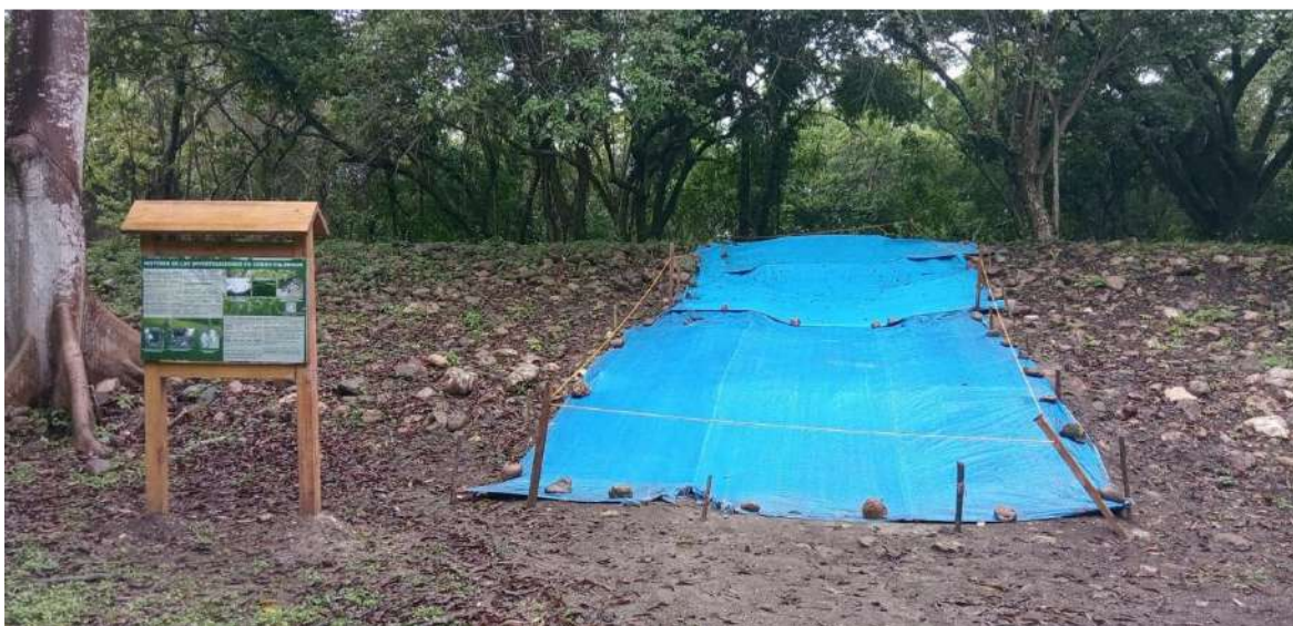
Ante las fuertes lluvias en el sitio, se tomó a bien protegerlo con el toldo durante la noche y durante el día que permanezca descubierto, expuesto al sol y al ambiente para que pueda consolidarse de mejor forma.
