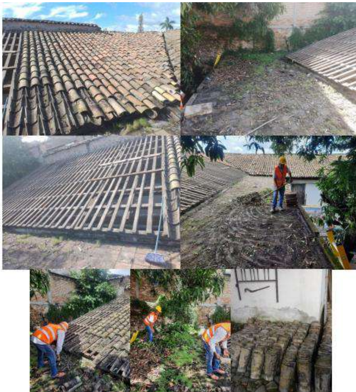
Imagen 6. Antes de la obra.
