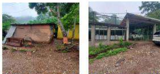
Vista de construcción de viviendas dentro del área de terreno
