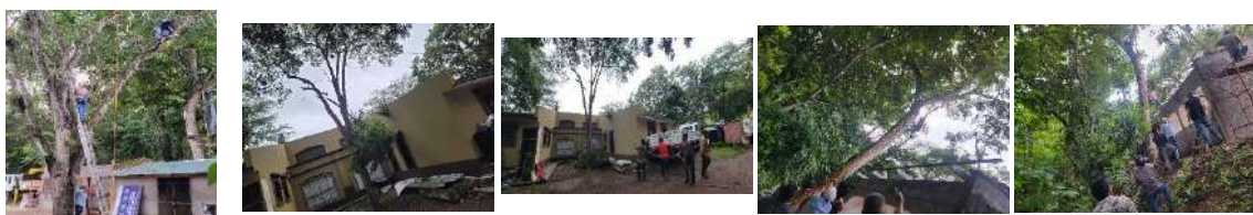
Poda de árboles cerca del centro de Visitantes y bodega de almacén
