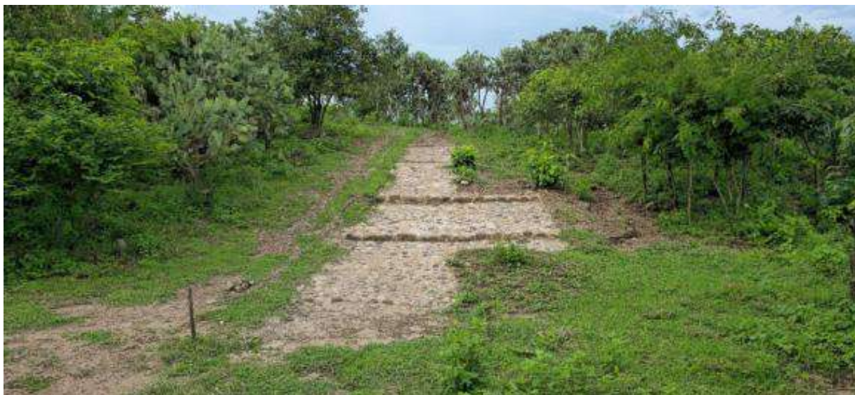
Estado actual de las restauraciones en la est-101 talud sur.
