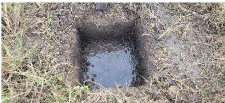
Solo se puede observar la primera capa y la segunda empieza a fluir agua por el nivel freático.
