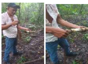
Reparación de tubería de agua que llega al CRIA
