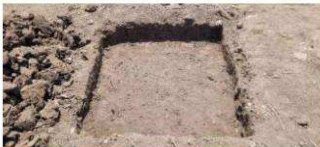
Después de quitar las piedras dispersas encontradas en las excavaciones de pozos.
