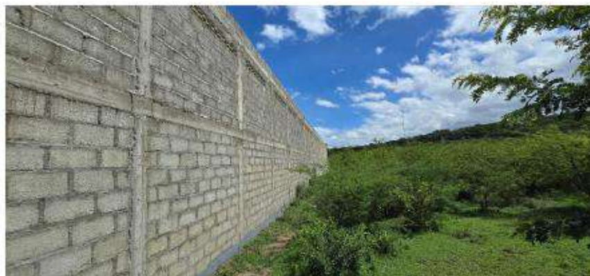
Imagen del espacio, vista desde el costado Oeste
