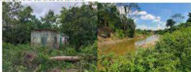
Vista de construcción en abandono y destruidas dentro del predio
