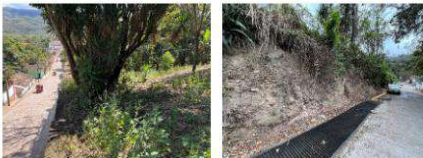
Fig. 6a, 6b, Colindancia al este, con avenida Los Sesesmiles y colindancia al sur con calle El escribano.
