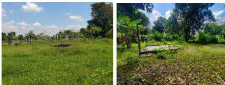
Vista de construcciones modernas viviendas en abandono y destruidas dentro del predio
