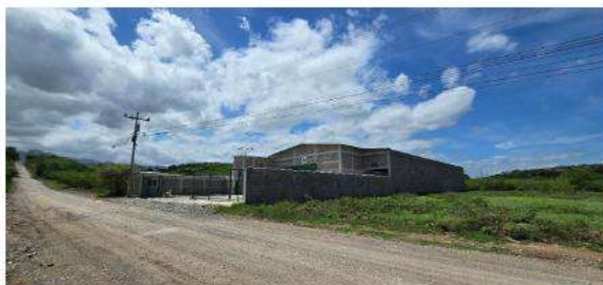
Imagen del espacio, vista desde el frente y costado Oeste
