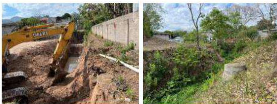
Fig. 6a 6b Retroexcavadora limpiando desagüe y pozos de alcantarillado.
