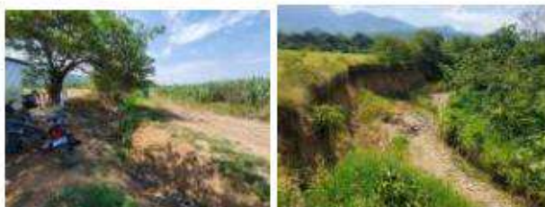
Vista de canal, quebrada, cañera y carretera colindantes
