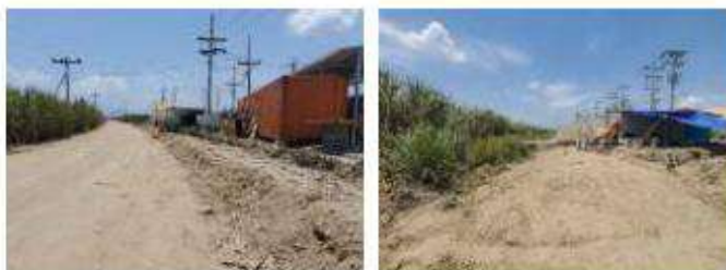
Vista de cañeras, Sub Estación y carretera pavimentada CA-13 colindantes al terreno
