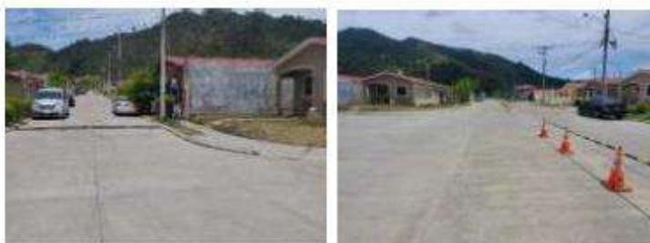
Vista de viviendas y calle colindante
