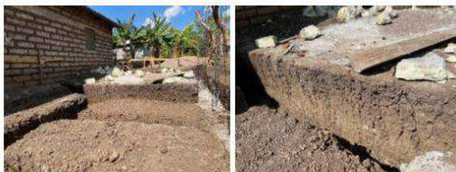
Fig.4a,4b: Área de construcción y cortes para cimentación de muros que muestran ausencia de vestigios arqueológicos
