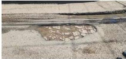
**Barrio abajo, se observa el adoquín bajo la capa asfáltica.**
