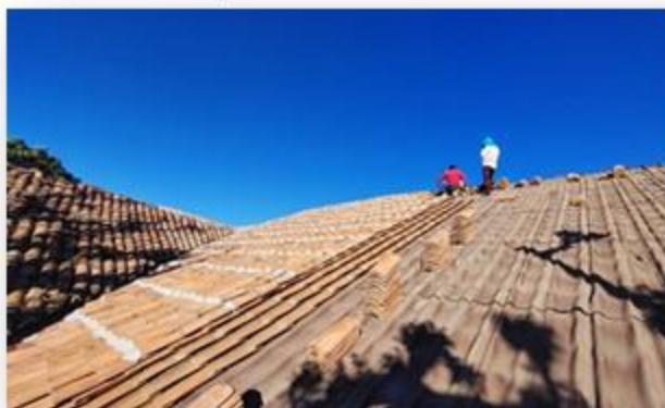
Labores de restauración
