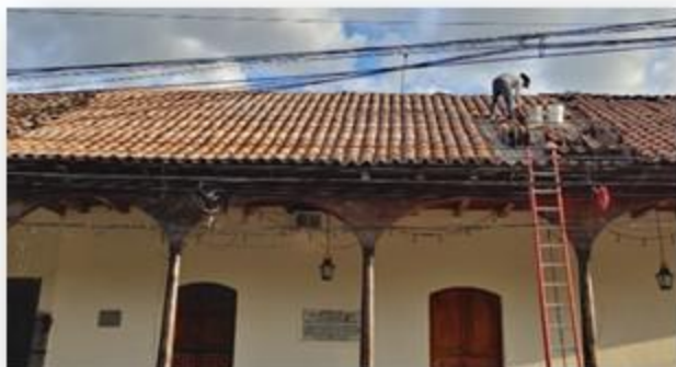
Labores de restauración
