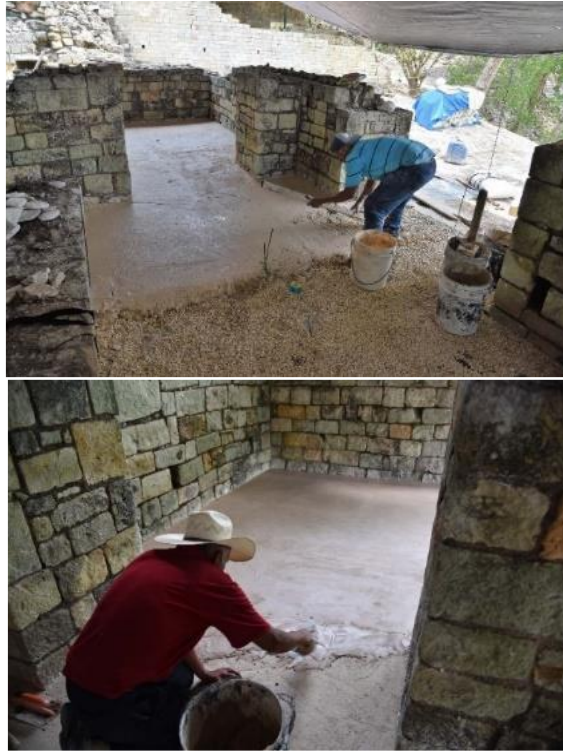
Trabajos de impermeabilización en proceso.
