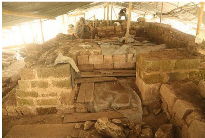
Vista del interior de las habitaciones de la Estructura 67E en proceso de restauración
