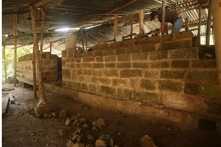
Vista de fachada norte de Estructura 67E en proceso de restauración
