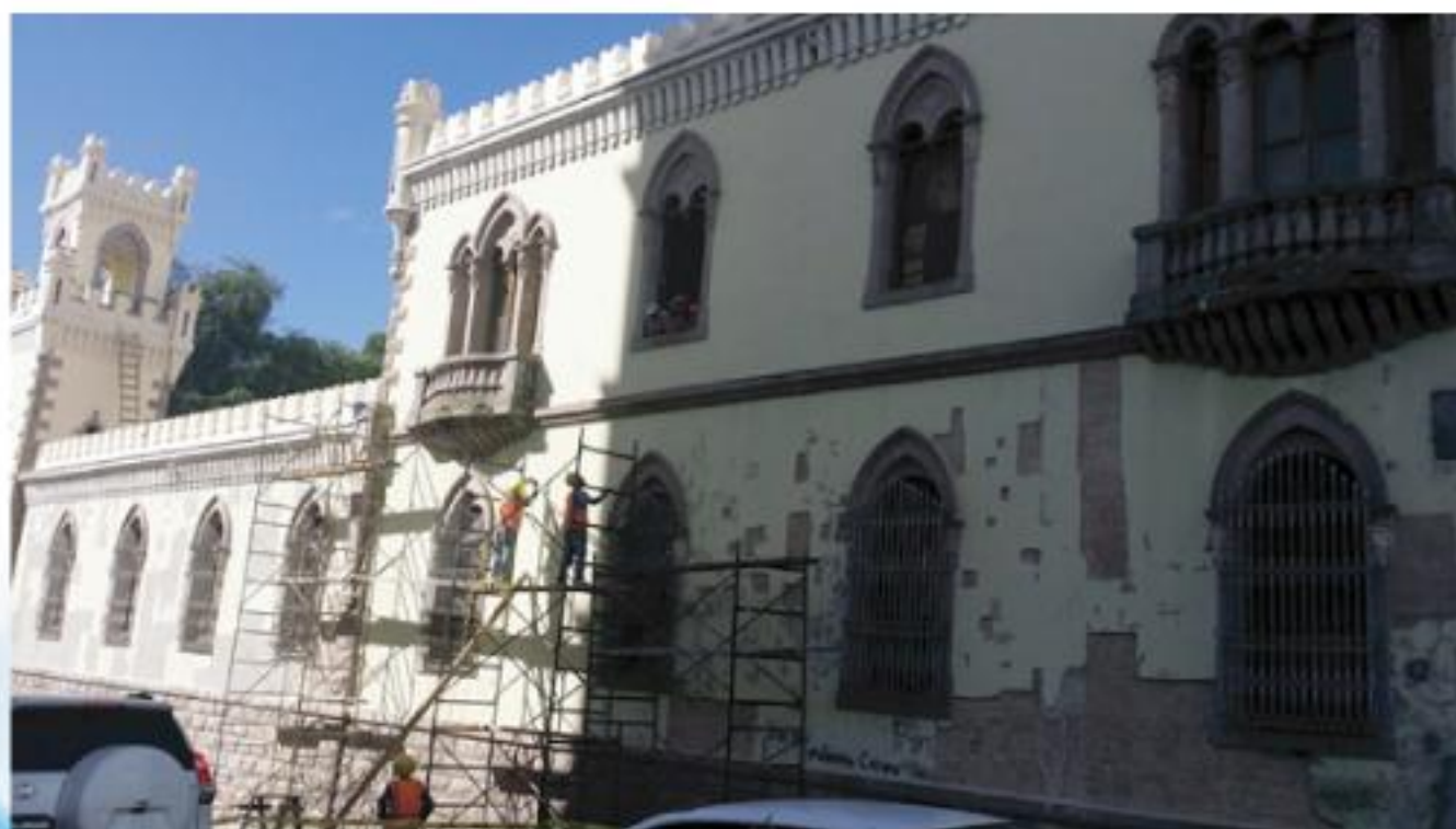
Resanes de paredes interiores y exteriores
