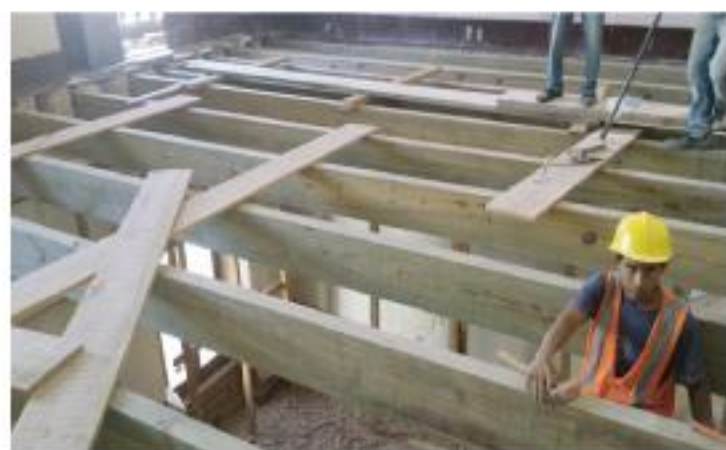
Cambio de losa de entrepiso de madera curada al horno, en Ala Norte
