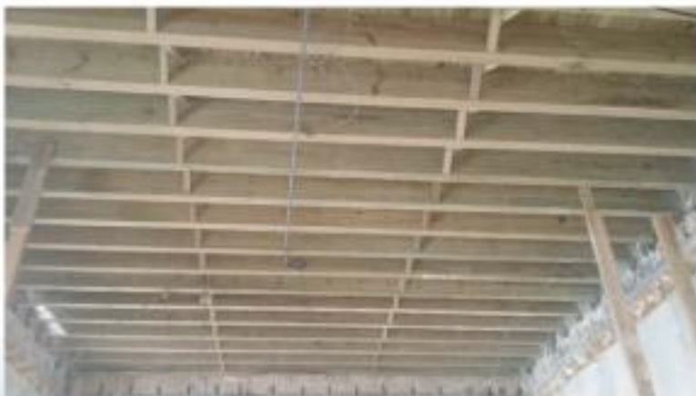
Cambio de losa de entrepiso de madera curada al horno, en Ala Norte
